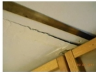
2. В результате осмотра окна кухни ниже расположенной квартиры №16 в целях определения перво-начальных размеров оконного проема были выявлены множественные дефекты в элементах отделки
